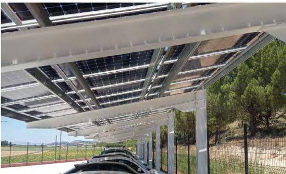
Marquesina metálica desmontable fabricada con vigas laminadas en caliente tipo IPE, con sección y espesor variable. Disponible en versiones sencillas y dobles según la distribución del aparcamiento, con acabados en pintura, lacado o galvanizado. Diseñada en cuatro versiones para adaptarse a las cargas de viento y nieve, cumpliendo con el Código Técnico de la Edificación (CTE). Su diseño industrial aporta robustez y atemporalidad.
