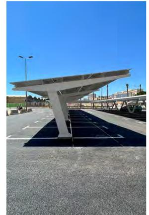
Nuestra marquesina metálica está fabricada con perfiles de tipo viga-cajón de sección y espesor variable, con uniones soldadas entre el brazo y el pilar para garantizar resistencia y estabilidad.
